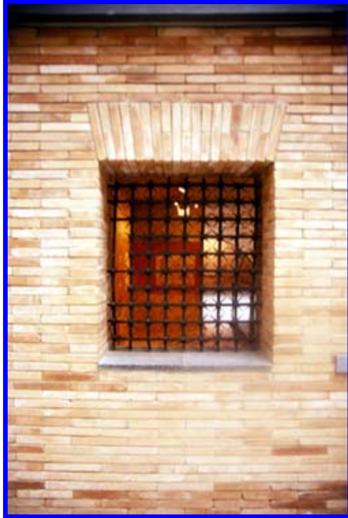
Ventana romana de hierro con aspas en sus ángulos para encajar módulos cuadrangulares de lapis specularis (Museo de Mérida)
